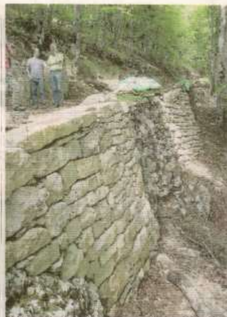
On distingue bien les parties restaurées de celles conservées en l'état.
